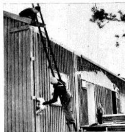
...som sågar upp husen i sektioner, vilka lastas på bilar och transporteras som »monteringsfärdiga»...
