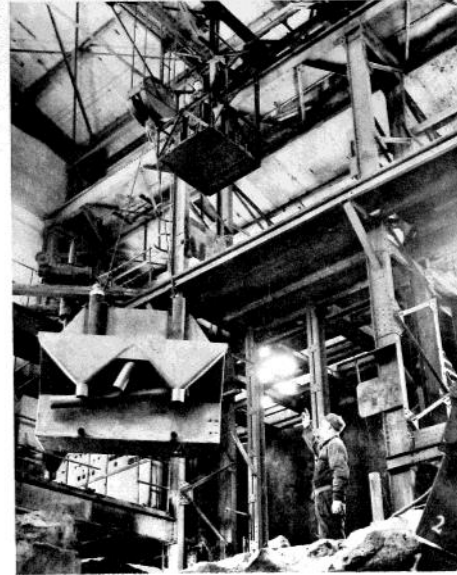
Anrikningsverket monteras ner. Här har en tung maskindel lossats från sitt fundament och lyftes med travers för transport till annan gruva. Montör Karl Lunberg leder arbetet.
