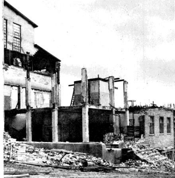
En del av stora huvudbyggnaden utgjordes av kontor. Tegel, rör, järnbalkar, sanitetsanläggningar — allt som kan användas på nytt tar man noga vara på för att transportera det till andra av bolagets anläggningsplatser i landet.
