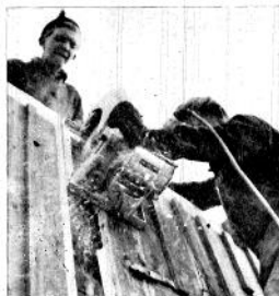
Sedan värmokare och elektriker plockat bort ledningar kommer »trägnarna» med el-drivna specialsågar...
