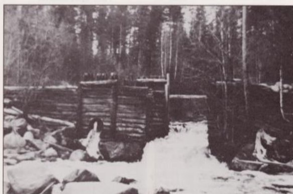
År 1918 påbörjade Johan Lindroth ett kraftverksbygge i Västra Pansikån, vilket när det hade färdigställts kom att betjuna Vidsel med omnejd under tiden maj-december. År 1945 övertogs det av Vattenfall och bilden ovan visar den på 1950-talet förfallna kraftverksdammen. Foto Ulf Ohman.
