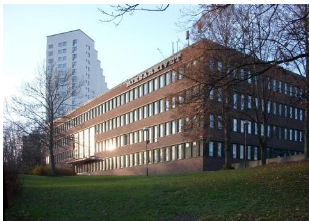
Riksarkivets huvudbyggnad i Stockholm.
