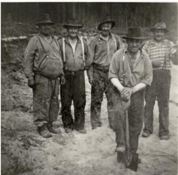
Här arbetas det på vägen i Bäckdal. Från vänster: Ludvig Sandberg , Johan Sjögren , Frans Olofsson , Med spaden Ernst Sandberg och Albert Nordlund . Alla från Bäckdal.
